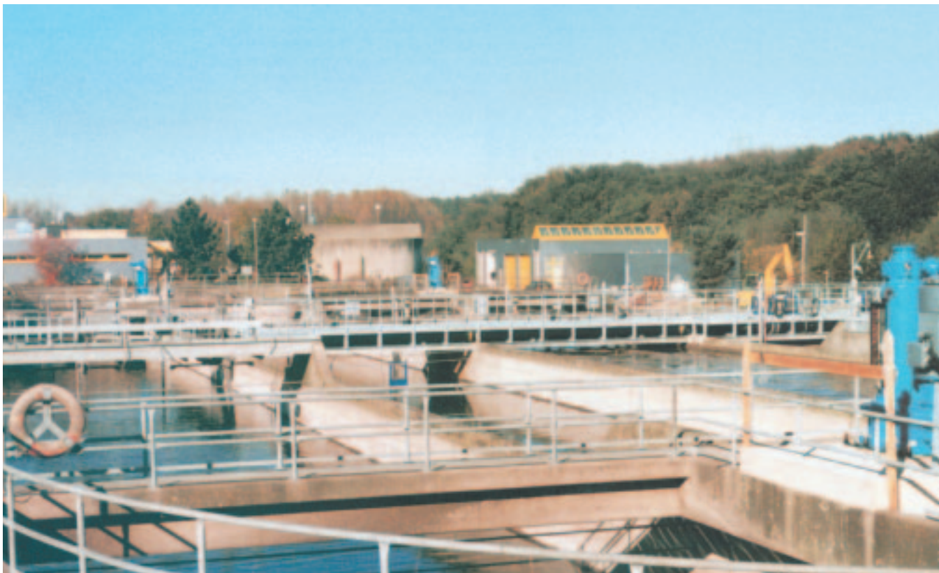
FLENDER-Zahnradgetriebe im Antrieb eines Belüfters FLENDER gear unit in an aerator drive FLENDER réducteur à engrenages dans l'entraînement d'un aérateur
